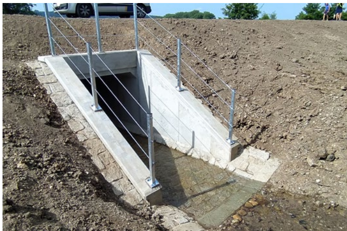
Komunikace a mostek Byšičky, realizace, investiční náklady 7 135 873 Kč
