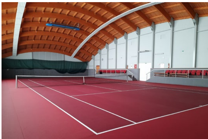
Tenisová hala sportovní areál Bažantnice „Nový povrch“, realizace, investiční náklady 1 263 204 Kč
