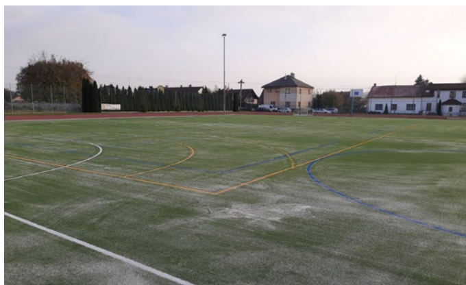
Rekonstrukce sportoviště u ZŠ (venkovní hřiště), realizace, investiční náklady 1 764 176 Kč
