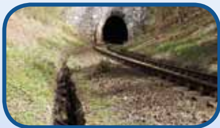
První přítok Heřmanky vytéká z tunelu
