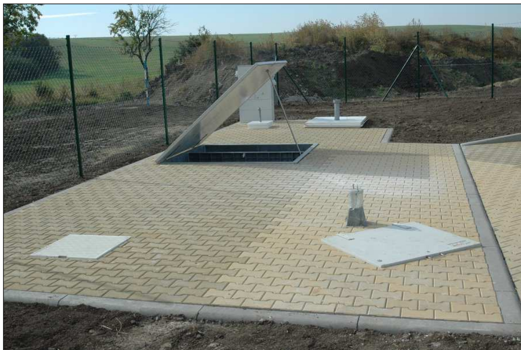
Obr.č. 13 – Příklad kontejnerové ČOV pro 150 EO (zdroj: ASIO, spol. s r.o.)
